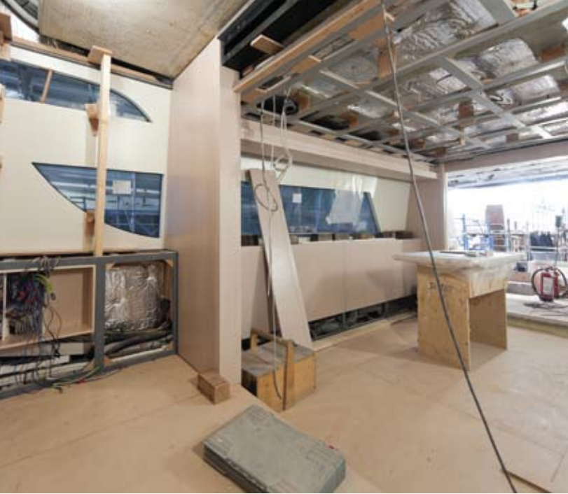
La zona Lounge-ponte coperta, in costruzione / Main deck Lounge, under construction
