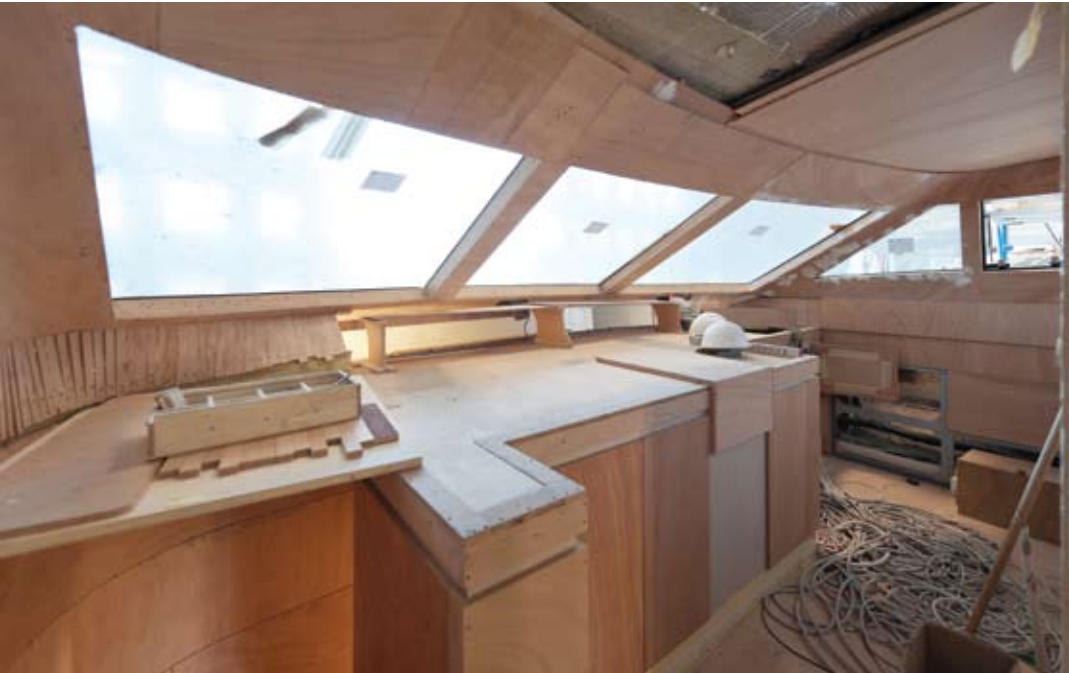
La cabina di pilotaggio, in costruzione / The wheelhouse under construction
