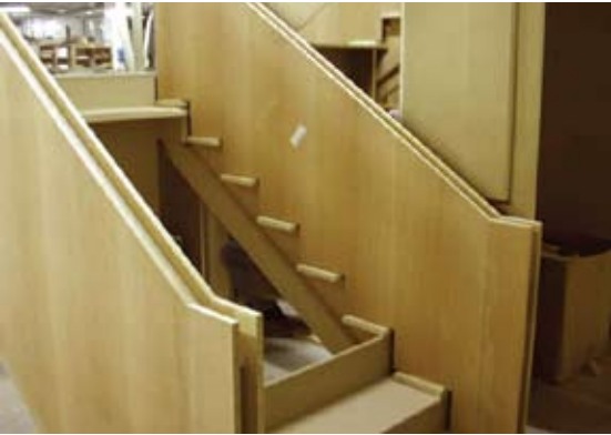
La scala completamente rivestita in legno in costruzione e nella realizzazione finale / The staircase, entirely cladded with wooden panels, under construction and final realization on site
