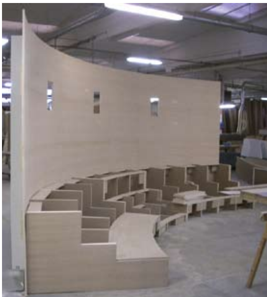
Il "teatrino" in costruzione / The "conference theatre" under construction
