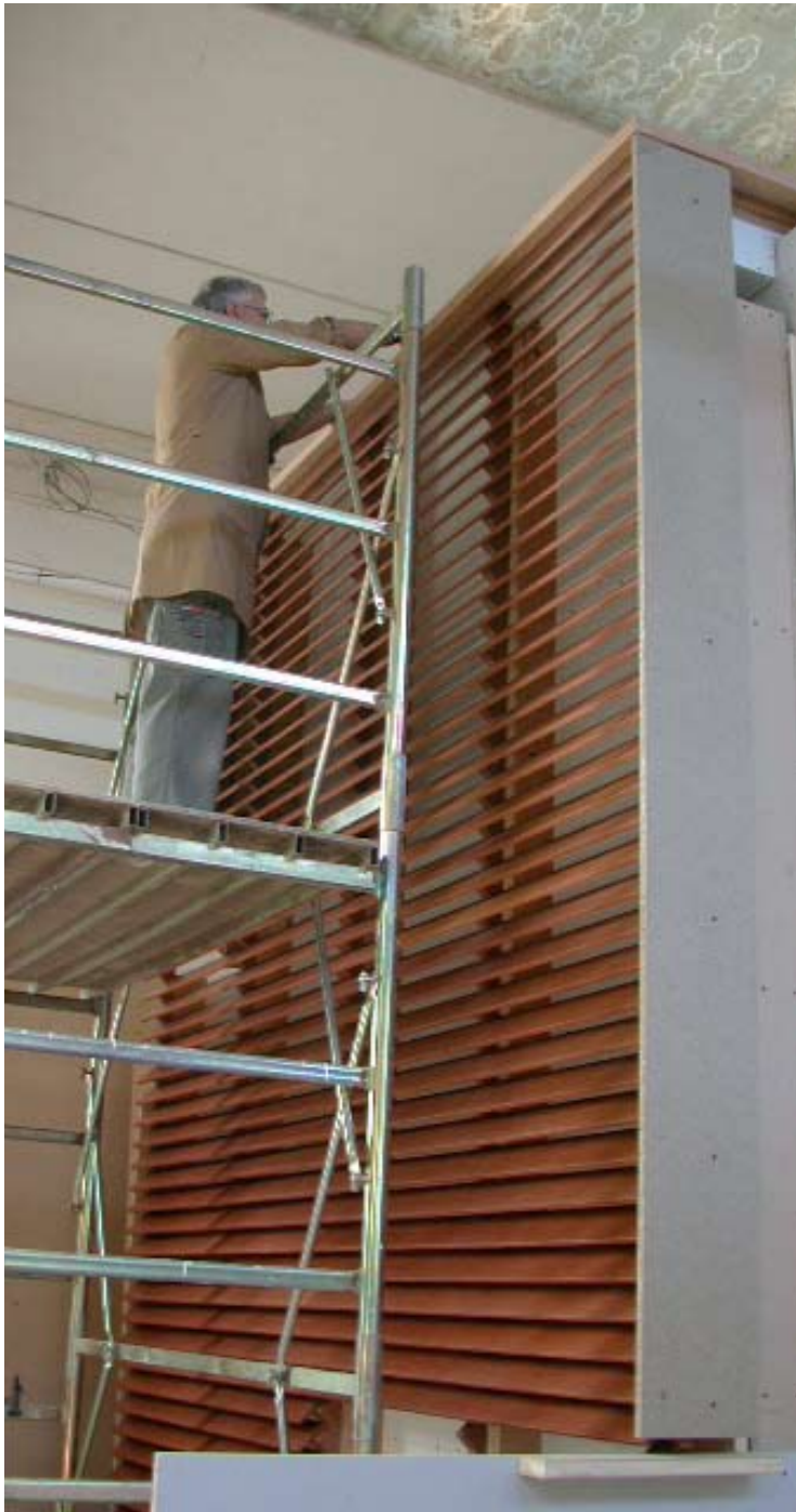
La parete a shed in legno della scala in costruzione nel nostro laboratorio / Backlit wooden shed under construction in our factory
